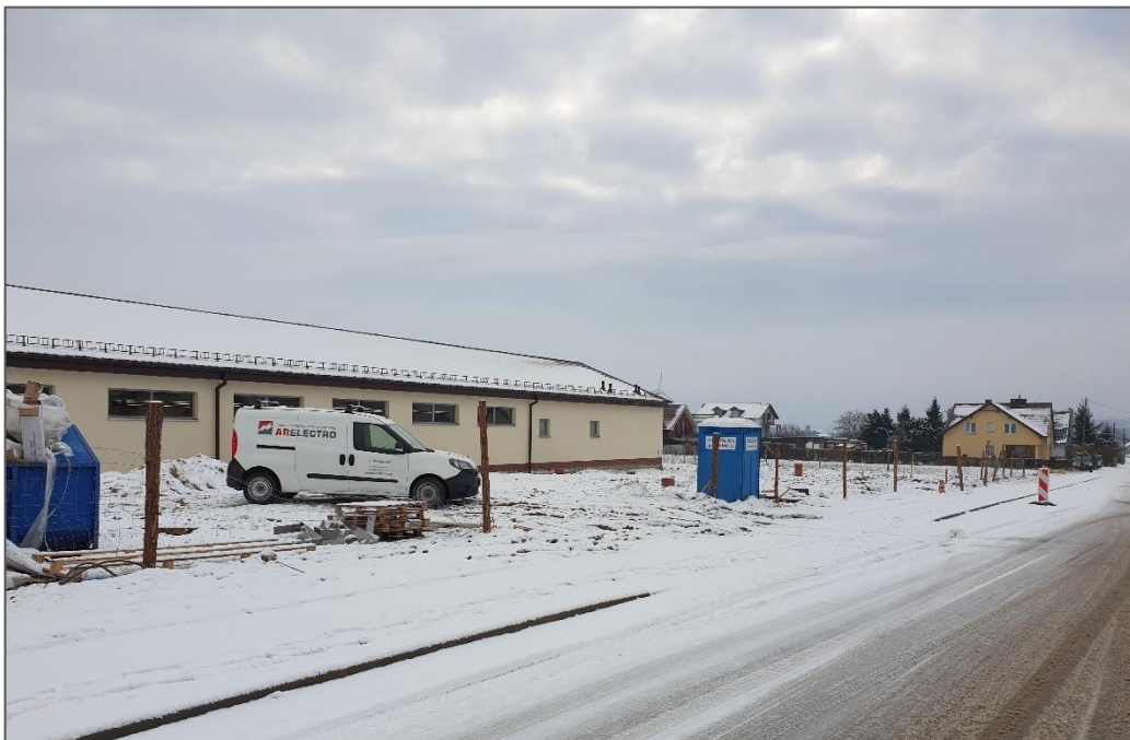
Fot. 6. Powstająca zabudowa usługowa na terenie C.1.MNU.
